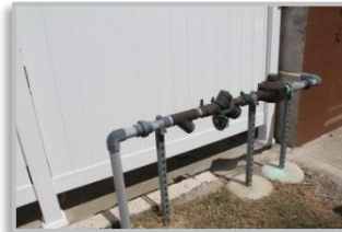
Figure 11: Drinking Water Risers to AV 32
