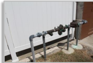
Figure 11: Drinking Water Risers to AV 32
