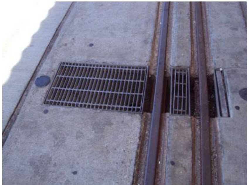
Hangar door drain.
